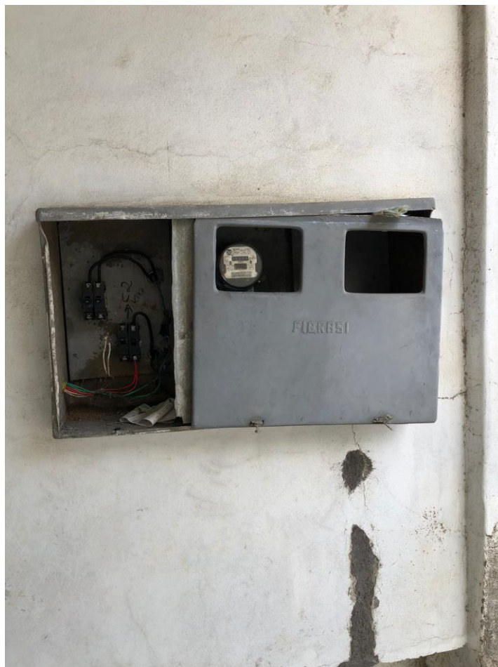
FOTO 05 – PADRÃO DE ENTRADA DE ENERGIA
