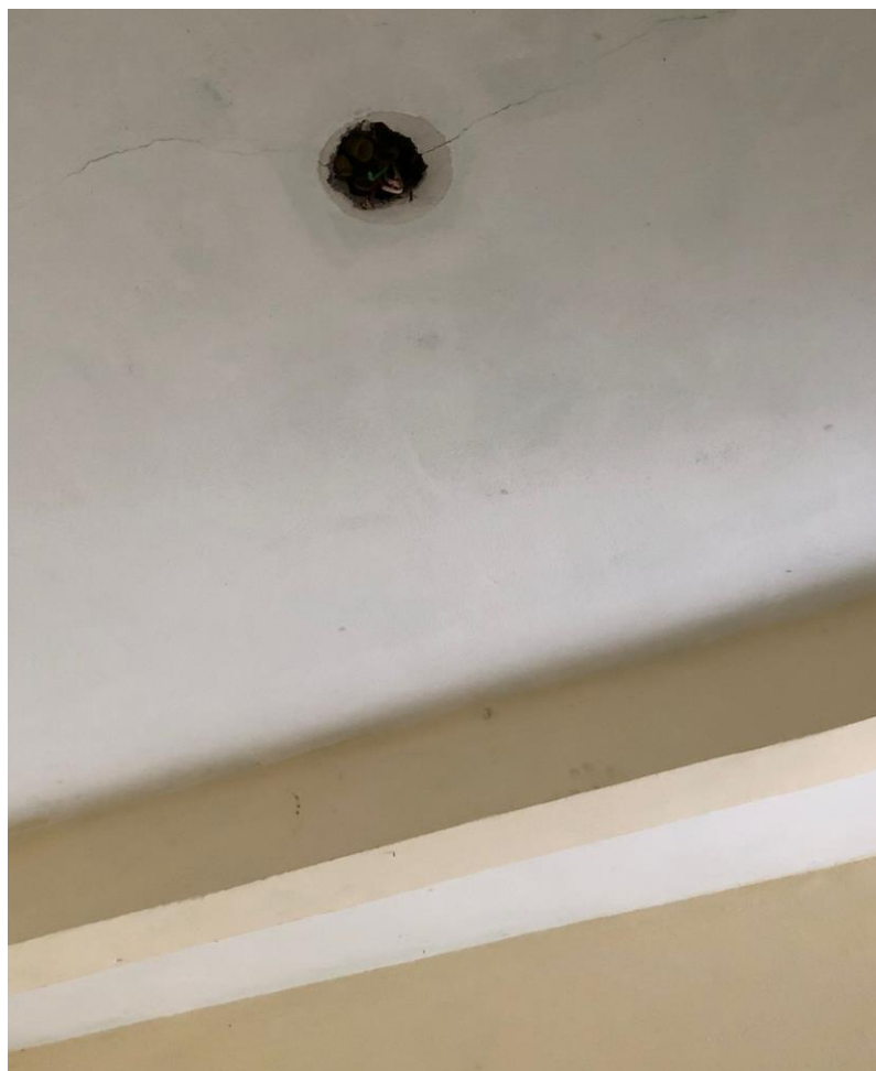
FOTO 10 – PONTO DE ILUMINAÇÃO SEM ACESSÓRIOS
