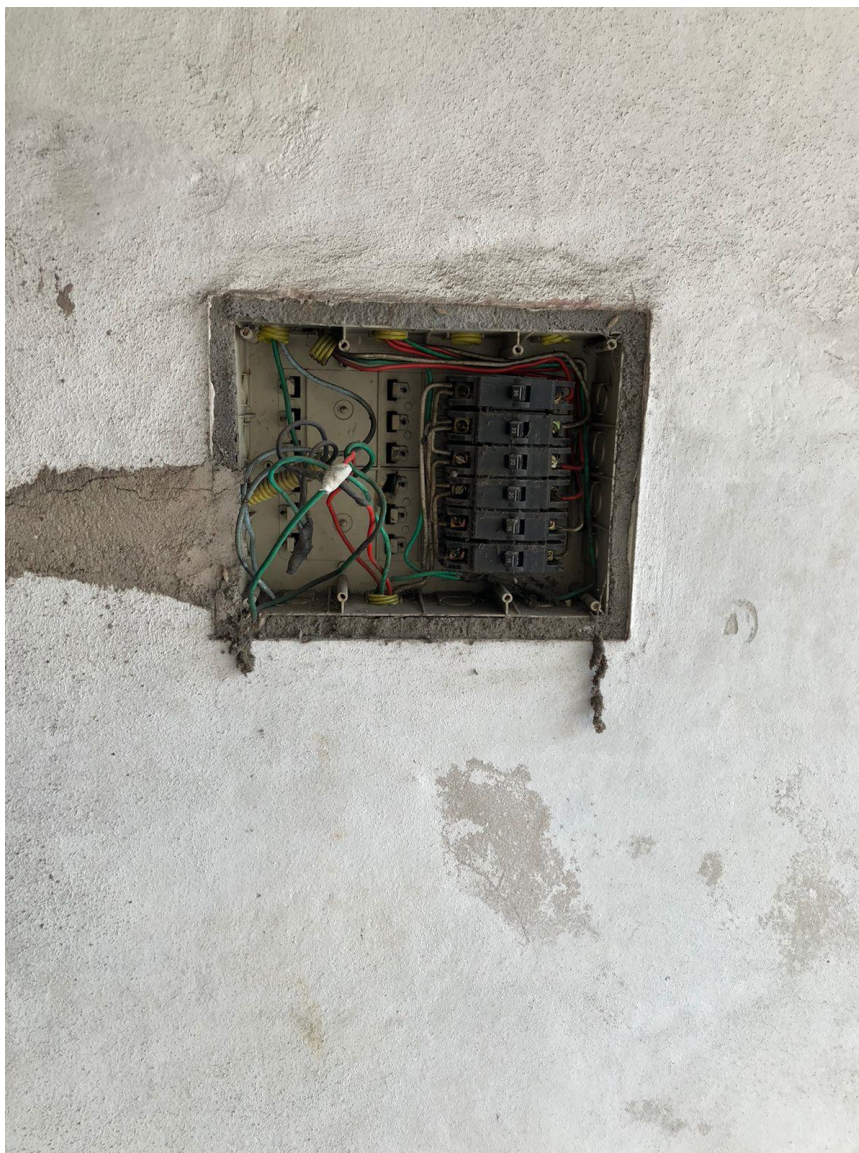
FOTO 07– QUADRO DE DISTRIBUIÇÃO DE ENERGIA
